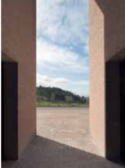
Paolo Zermani. Chiesa di S. Giovanni a Ponte d'Oddi, Perugia (foto di Mauro Davoli).
